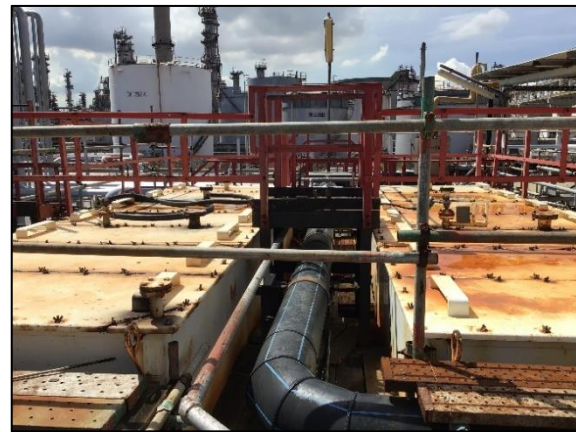
รูปที่ 2-8 ระบบ API Separator
